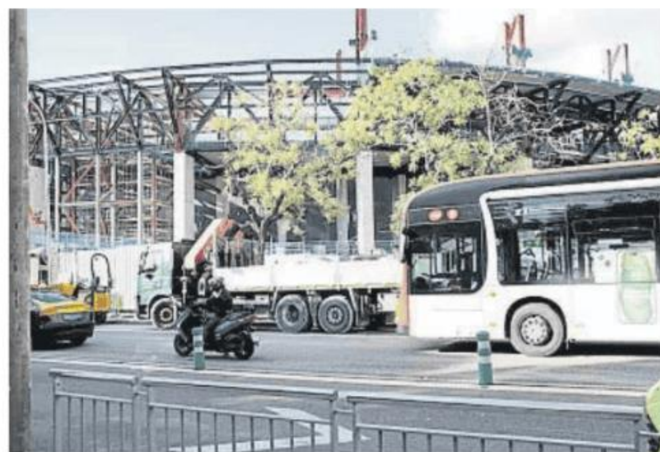
Vista exterior del estadio en obras desde Travessera de Les Corts
